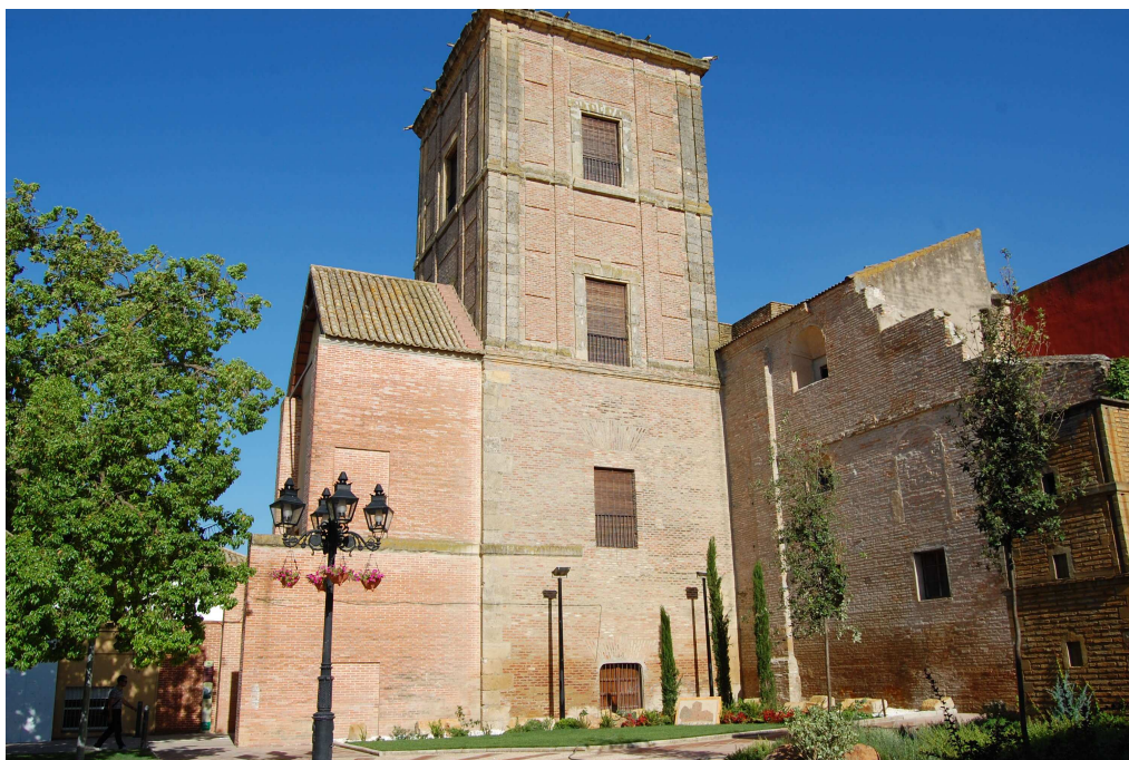
Vestigios que se conservan actualmente del Palacio de los marqueses de Guadalcázar.
