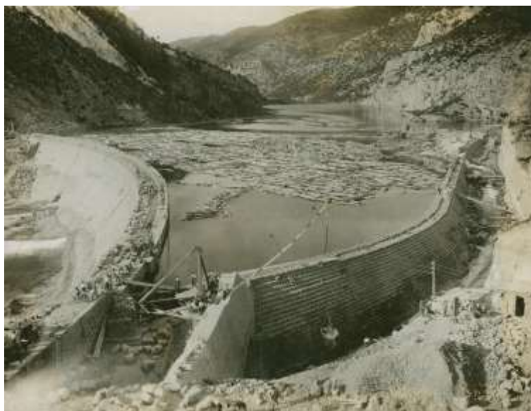
Figura 2. Llegada de una maderada a la presa de Bolarque en construcción (1909), con el aliviadero a la derecha de la imagen, que aún no estaba operativo. Naturgy. Archivo del Museo de Bolarque, BO-Museo-617-037
